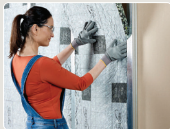
Pose rapide de Simfocor entre les montants métalliques
