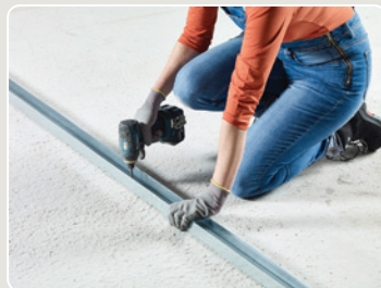
Installation d'une ossature métallique standard
